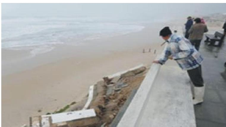
**Figure 14** – Érosion côtière et destruction du mur de support de la route littorale de la plage de Pedrógão (zone littorale de la municipalité de Leiria – février 2014, <http://www.diarioleiria.pt>).
