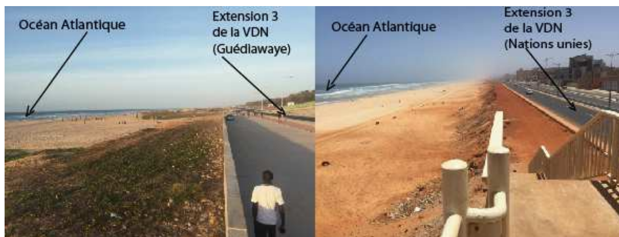
Photo 3 - Extension 3 de la Voie de Dégagement Nord (Guédiawaye et Nations Unies).
