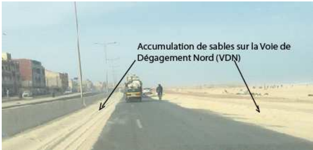
Photo 5 – Accumulation de sables sur l’extension 3 de la Voie de Dégagement Nord (VDN 3)
