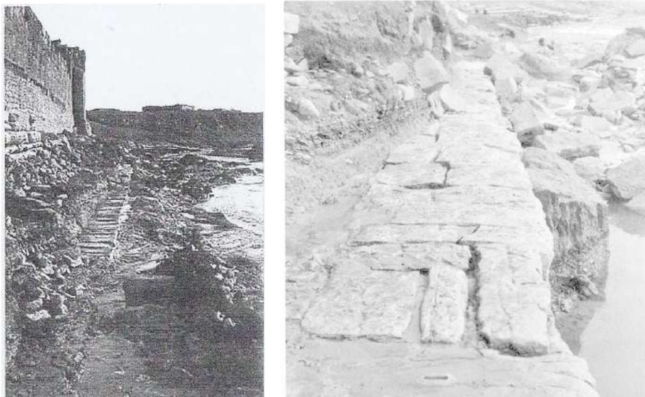
**Fig. 9 a et b** *Ammaedara* (Haïdra, Tunisie). Le quai de protection contre l'oued au pied de la citadelle byzantine d'*Ammaedara* (Haïdra / Tunisie). Source : BARATTE 1996 et 2012.
