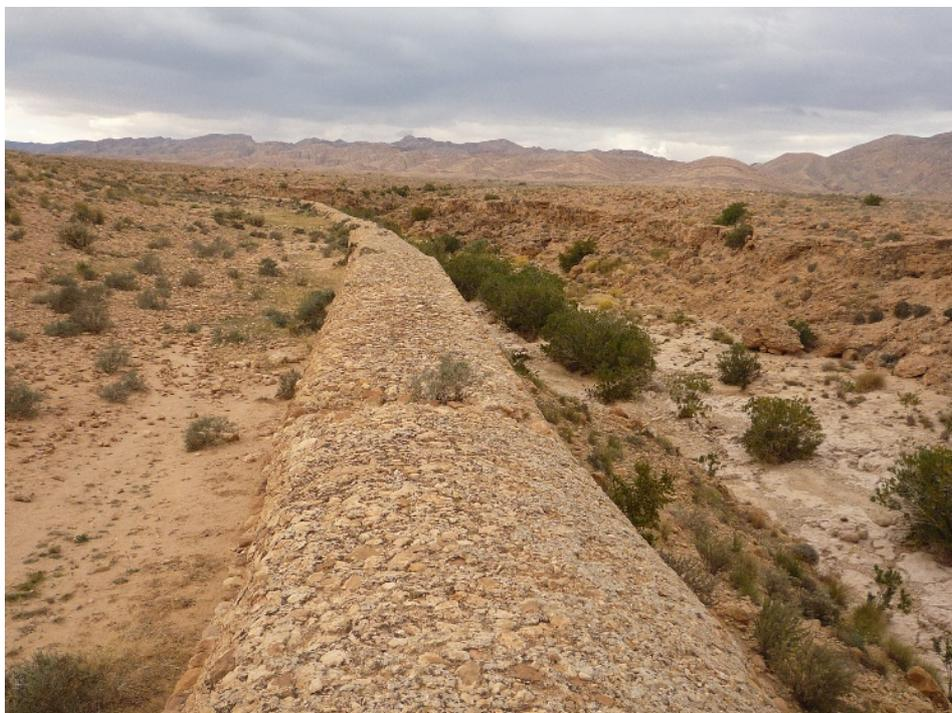
**Fig. 2a.** Mur de dérivation des eaux de l'oued Haddej (Bouhedma). Fareh, H.
