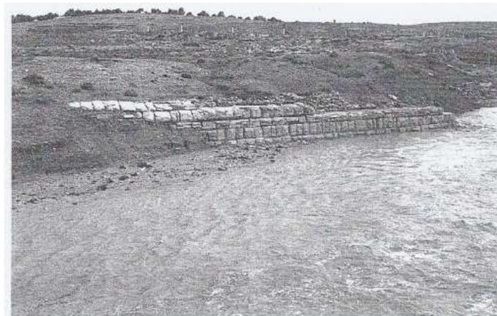
**Fig. 8** *Ammaedara*, digue dans l'oued (source : Baratte, 2012 : 155)
