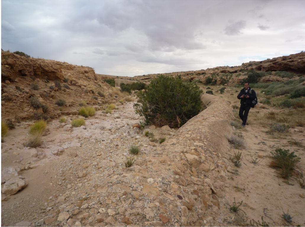
**Fig. 2b.** Mur de dérivation des eaux de l'oued Haddej (Bouhedma) : le partage de l'eau au niveau du lit mineur de l'oued. Fareh, H.
